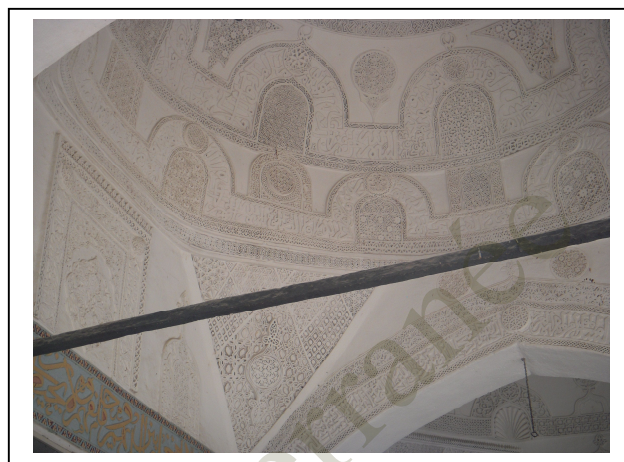
fig. 13 - Décor des coupoles du portique sud d'al-Bakiriyya. © cliché de l'auteur
