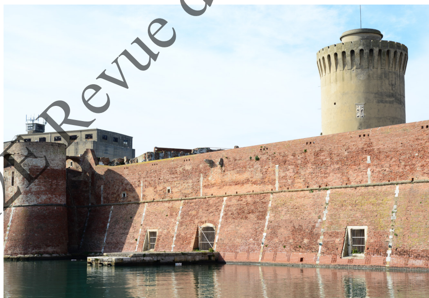
fig. 10 - Vue actuelle de la Porte du Secour (Photographie de Paolo Pampana)
