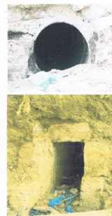
قنوات مياه مغمورة
